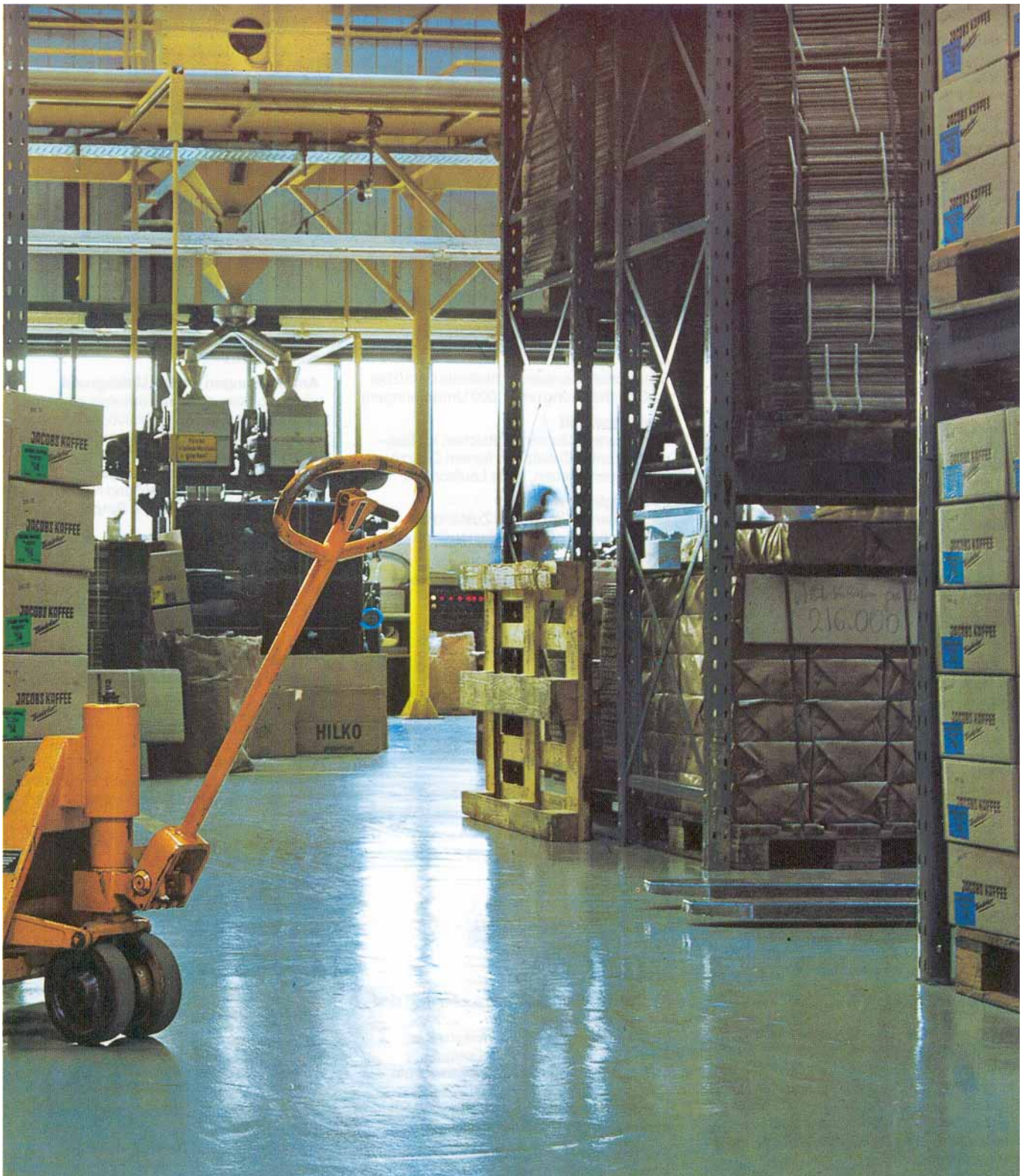
Lagerhalle, Versiegelung mit astra®-Betonimprägnierung
